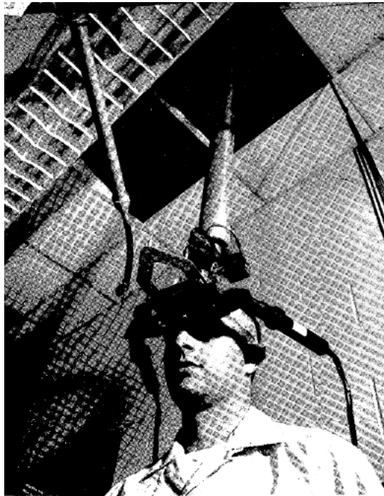
Abbildung 2.2: Bild von Sutherland (1968)s HMD
